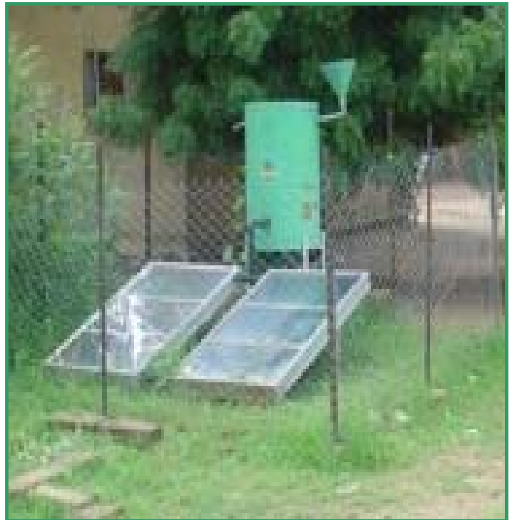
Figure 8 : Chauffe-eau solaire installé dans la cours du dispensaire de Konondimini
